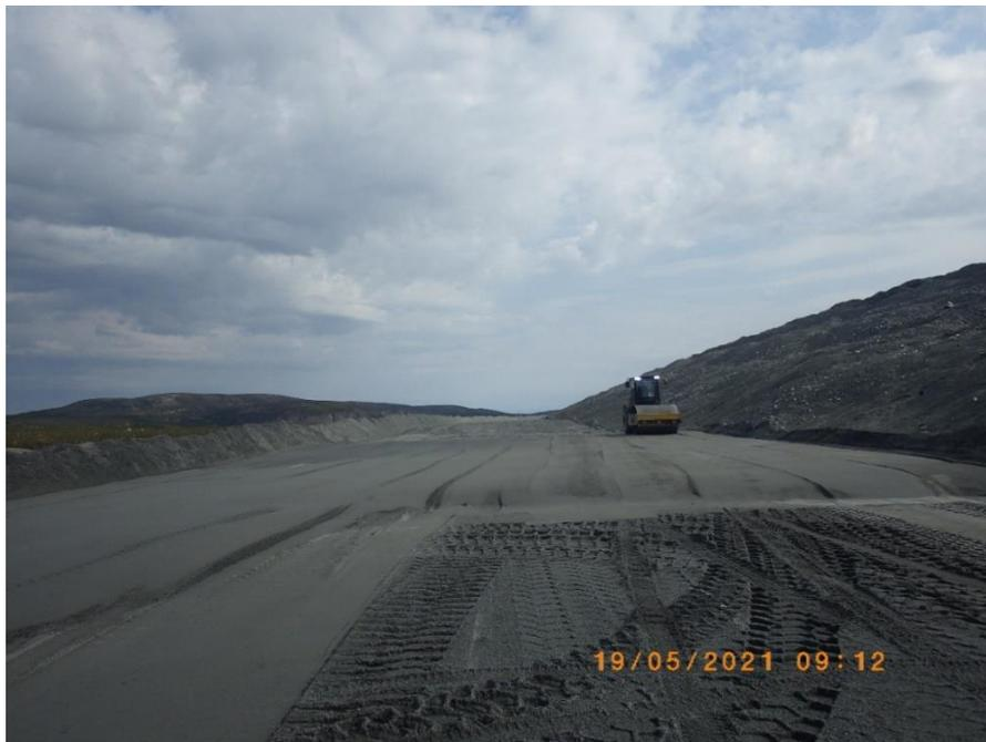
**Photo 3.54** Déposition et compaction de la kimberlite usinée (fraction grossière) pour rehausser un palier en aval du centre ligne
