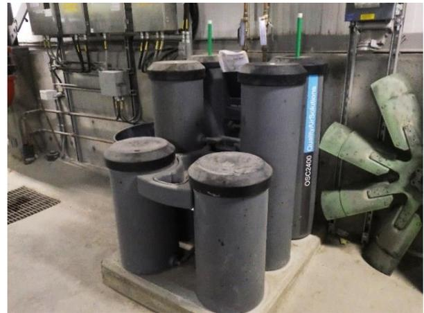
**Photo 3.51 Séparateur des condensats de la remontée d'air frais (FAR)**
