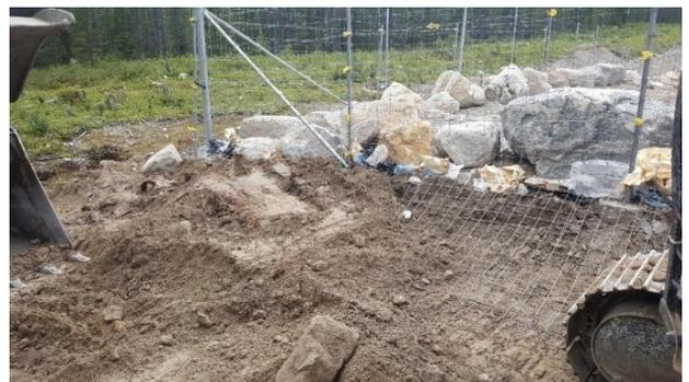
Photo 3.42 Renforcement de la clôture au LEET
