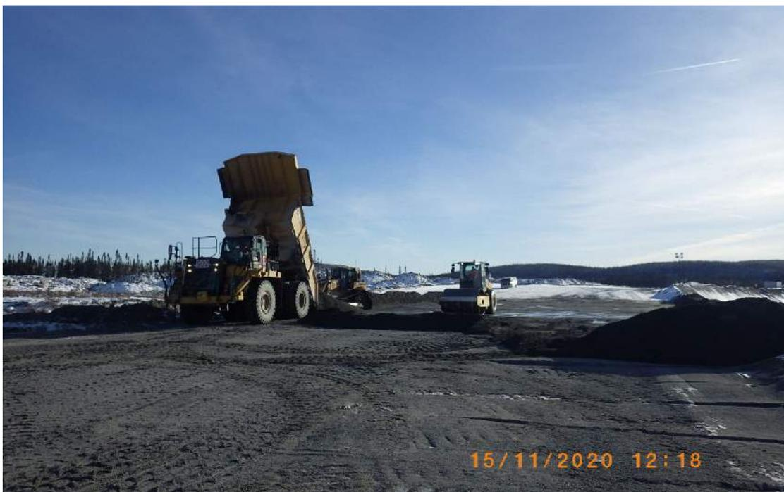
**Photo 3.50** Déposition et compaction de la kimberlite usinée (fraction grossière) pour rehausser un palier en aval du centre ligne
