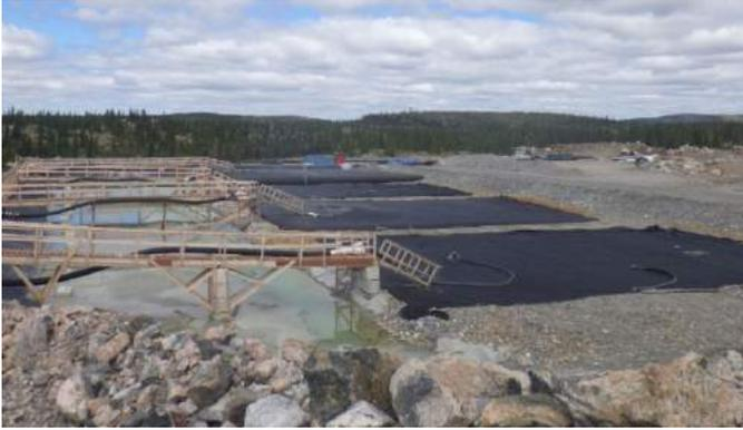
**Photo 3.45 Usine de traitement modulaire avec sacs filtrants nommés Geotube®**
