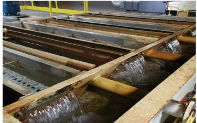
**Photo 3.44 Aspect visuel de l'eau traitée à la sortie des décanteurs lamellaires**
