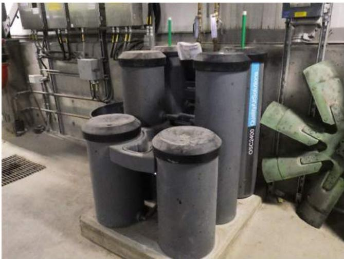
**Photo 3.47 Séparateur des condensats de la remontée d'air frais (FAR)**
