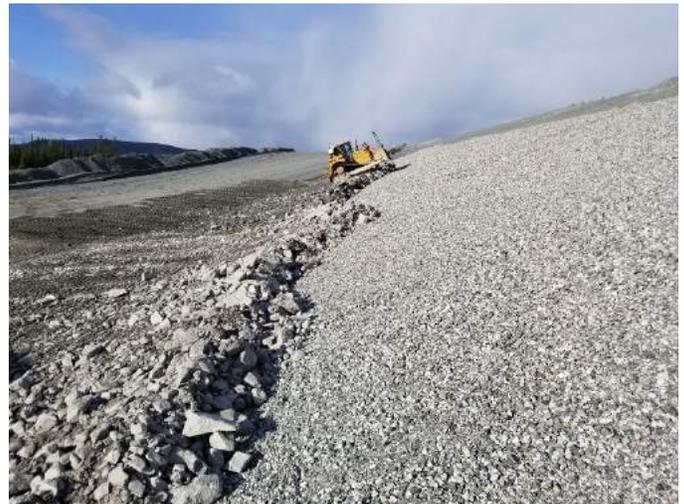
**Photo 3.51 Mise en place de la couche de pierre pour la fermeture progressive du talus ouest**
