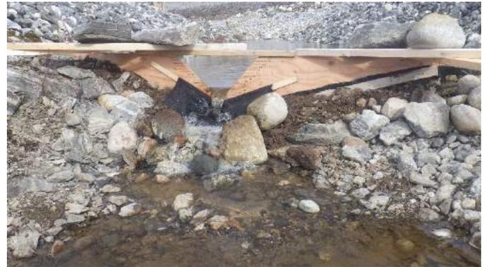
**Photo 3.30 Déversoir en V gradué dans l'exutoire
