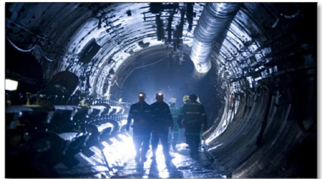
Photo 4.1.3 Installations minières souterraines
