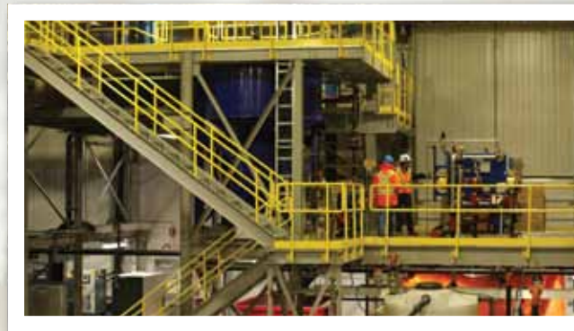
Avril 2016 - Usine de traitement des eaux minières
